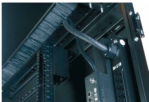
Аппаратурная стойка серии RP с двумя установленными ePDU
